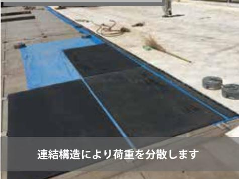
連結構造により荷重を分散します
